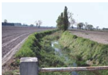
Enfoncement du cours d'eau suite à un recalibrage
