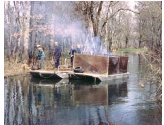
Barge permettant un entretien de la ripisylve depuis le cours d'eau
