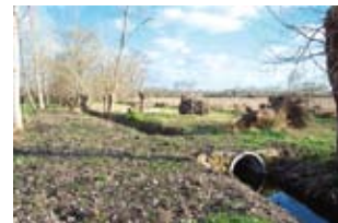
Ouvrage de franchissement d'un fossé
