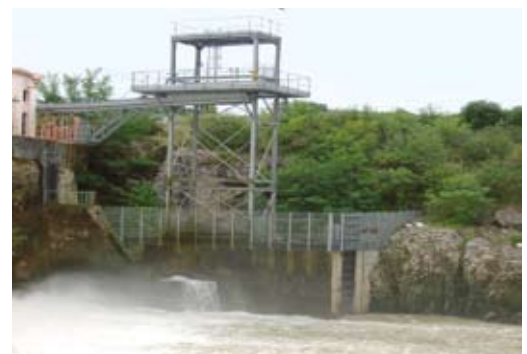
Ascenseur à poissons
