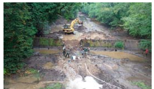
Pêche électrique préalable à l'effacement de la digue de Chambon
