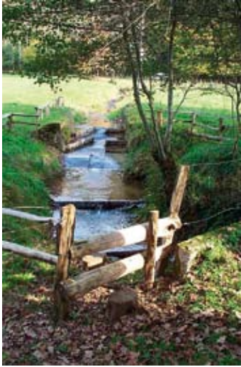
Différents aménagements piscicoles : petits déflecteurs, seuils, blocs de pierre
